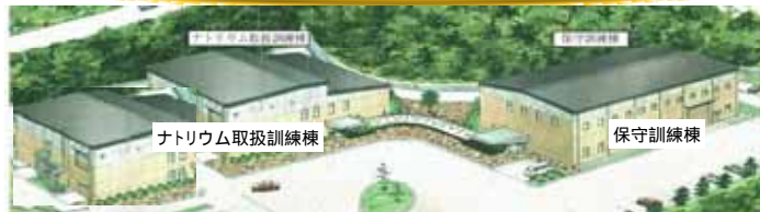
プラント実環境研究施設
